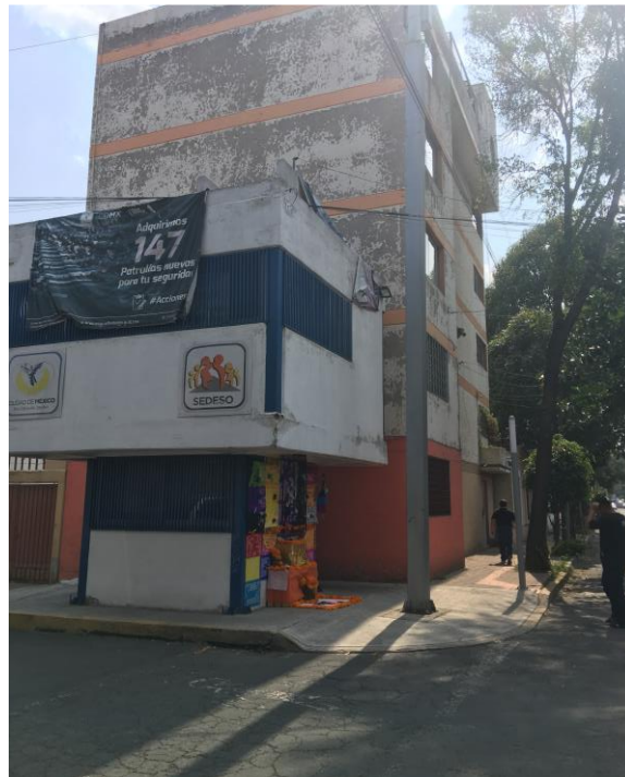
Figura 18. Foto módulo de seguridad Lago Guanacacha
