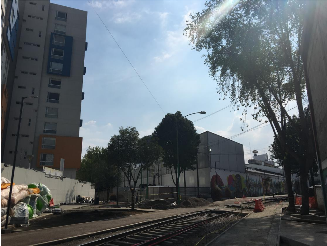
Figura 8. Obra Parque Lineal Ferrocarril de Cuernavaca
