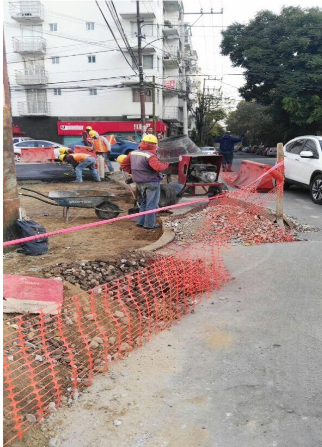
Figura 32. Imagen vecino Jorge Reyes guiando tránsito y supervisando obra, diciembre 2017
