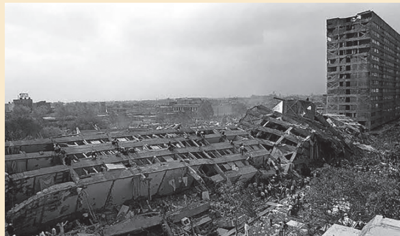
*Colapso parcial del edificio Nuevo León
